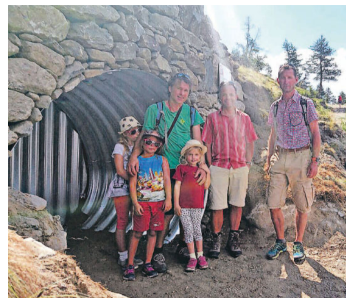
Schutzunterstand. Geologe Eric Pointner, Mario Fuchs, Gemeindepräsident von Täsch, und Klaus Tscherrig vor einem der fünf neuen Schutzbauten im «Täschwang».
